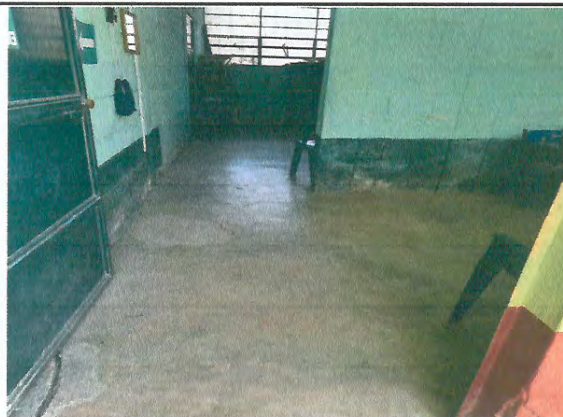
Foto 4: Mejoramiento de Pintura Interior y Exterior
