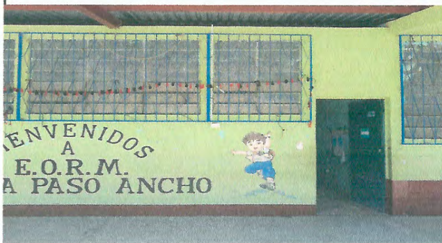
Foto 3: Mejoramiento de Pintura Interior y Exterior
